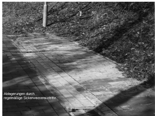
Abb. 2: Sickerwasseraustritte auf Wegen der Anlage
