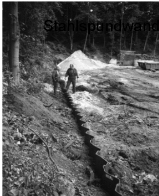
Abb. 9: Abdichtung des Deponiekörpers im Abstrom
