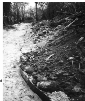
Abb. 8: Abdichtung des Deponiekörpers im Anstrom
